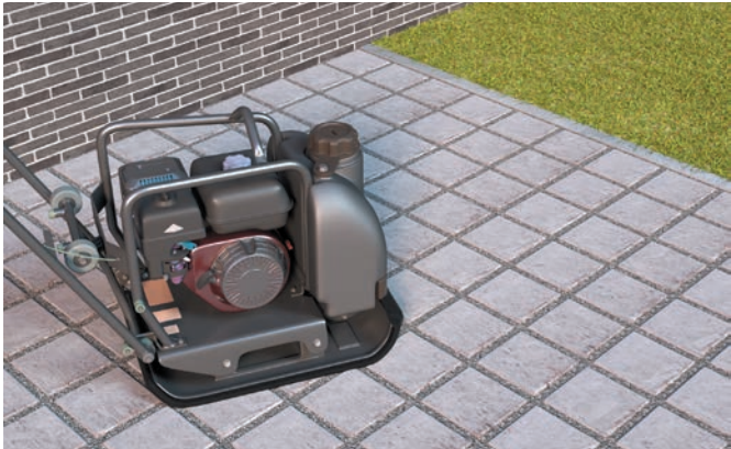
Aftrillen met trilplaat voorzien van rubberen zool
