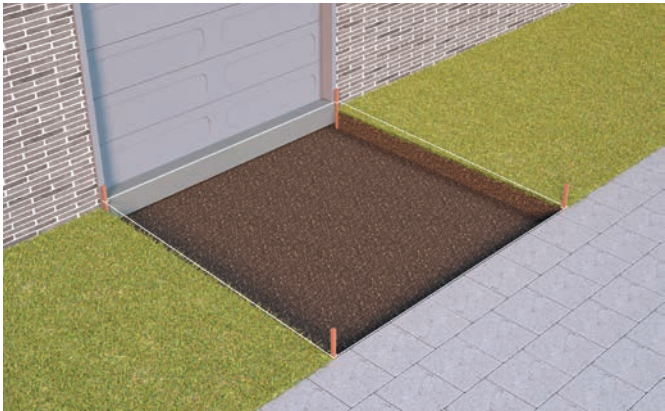
Uitzetten met piketten en niveau bepalen
