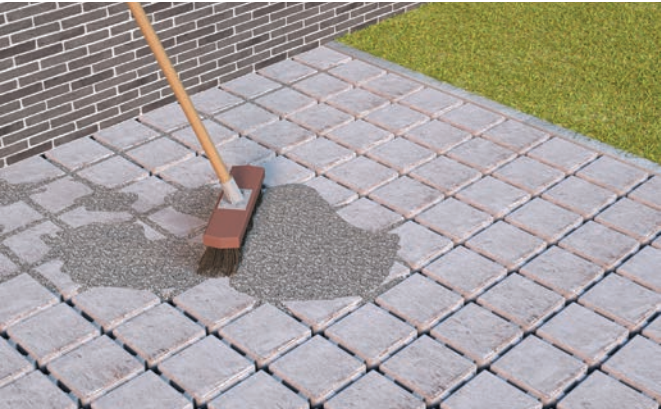
Opvullen met waterdoorlaatbare voegsplit
