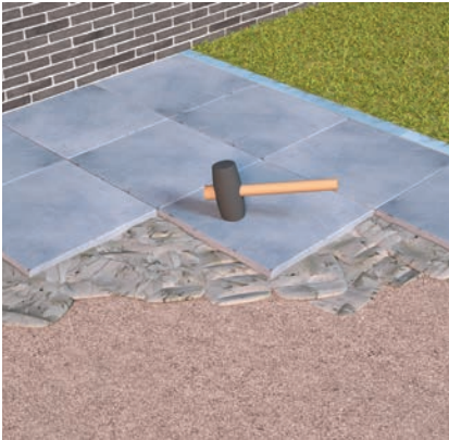
Plaatsing tegels in de legmortel op stabilisé
