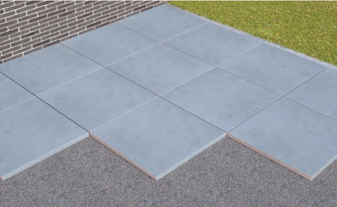
Losse plaatsing op grind
