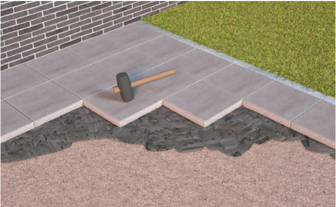
Plaatsing tegels aankloppen met rubberen hamer
