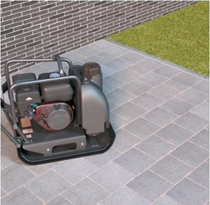
Afrillen met trilplaat voorzien van rubberen zool
