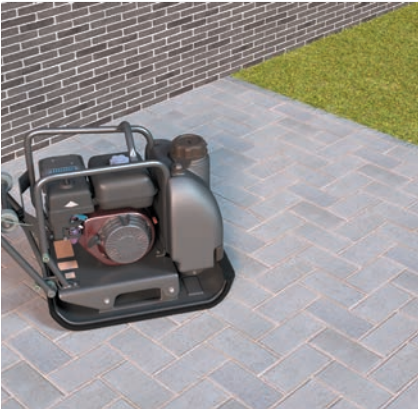
Afrillen met trilplaat voorzien van rubberen zool
