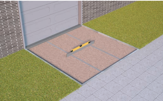
Fundering straatlaag, nivelleren met paslatten
