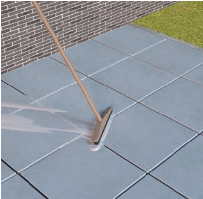
Voegen met voegmortel en voegrubber
