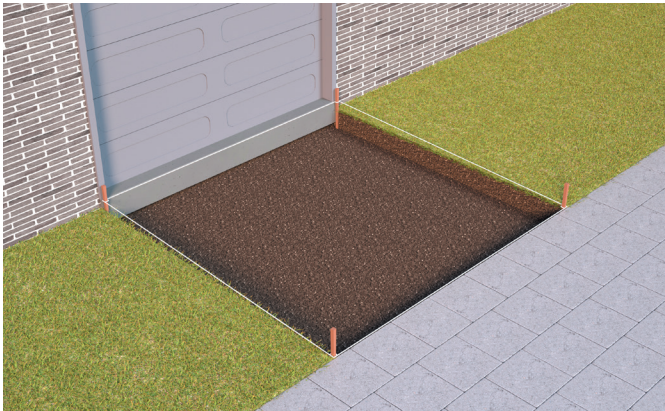
Partez avec des piquets et déterminez le niveau
