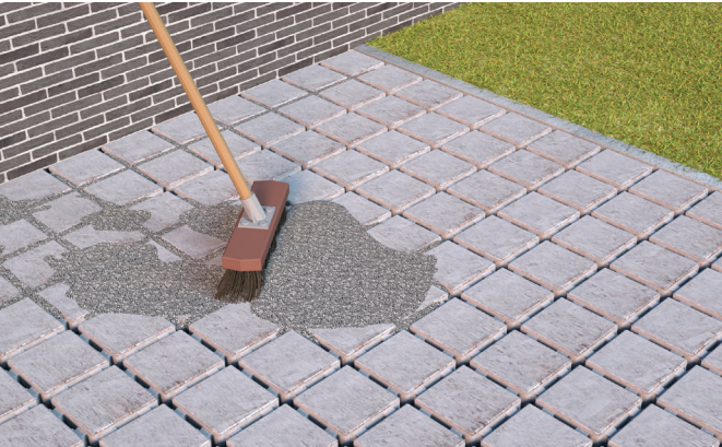
Remplir avec du gravillon de jointoiement perméable
