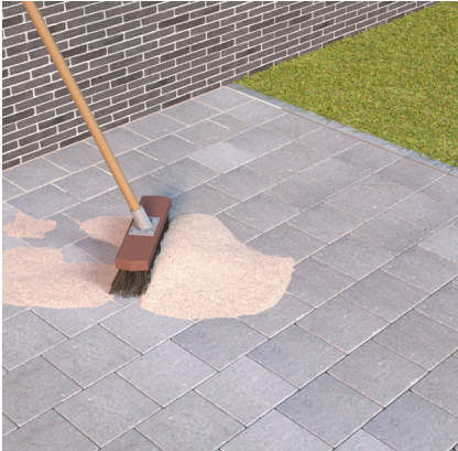
Brossez-les avec du sable de jointement / sable bio
