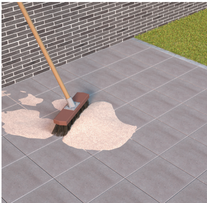
Brossez-les avec du sable du jointoiment (pose sans joint)
