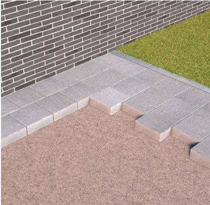
Placement sur stabilisé en appareil à mi-brique
