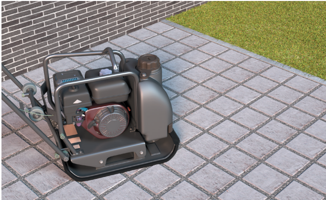
Damer avec une plaque vibrante munie d'une semelle en caoutchouc
