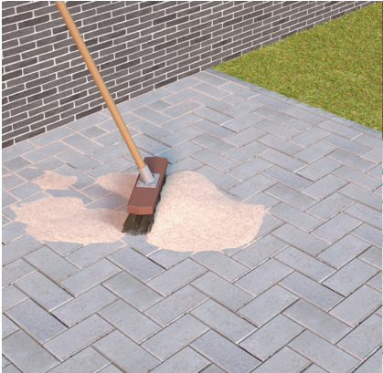
Brossez-les avec du sable de jointoiement / sable bio
