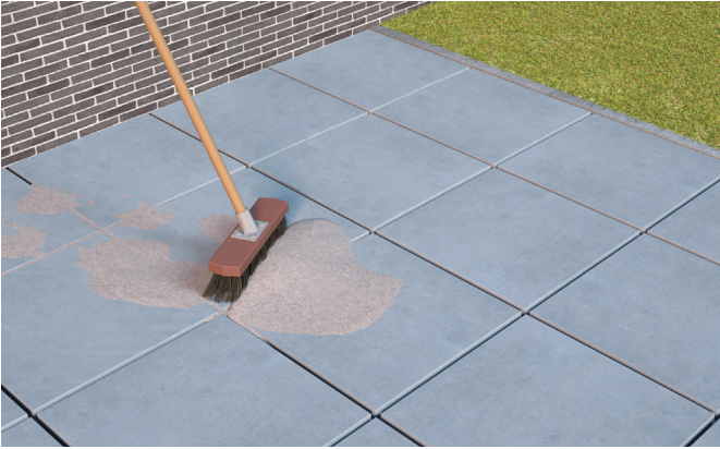
Rejointoyer avec sable de jointoiement ou gravillon
