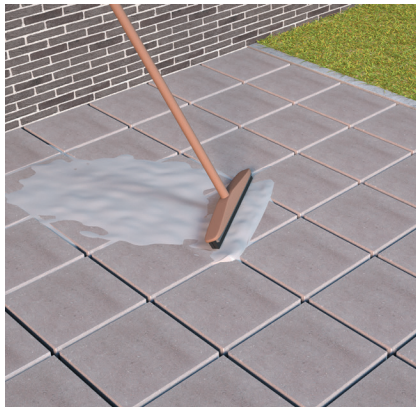
Remplir avec un produit de rejointoiment (pose avec joint)
