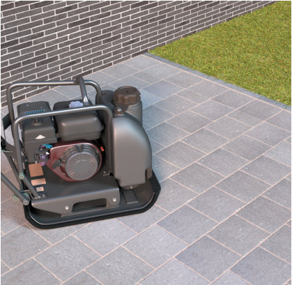
Damer avec une plaque vibrante munie d'une semelle en caoutchouc
