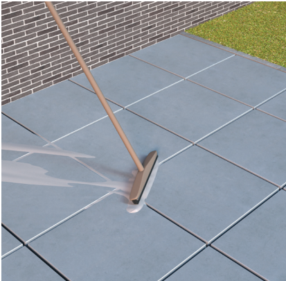
Remplir avec un produit de rejointoiement et raclette à joints
