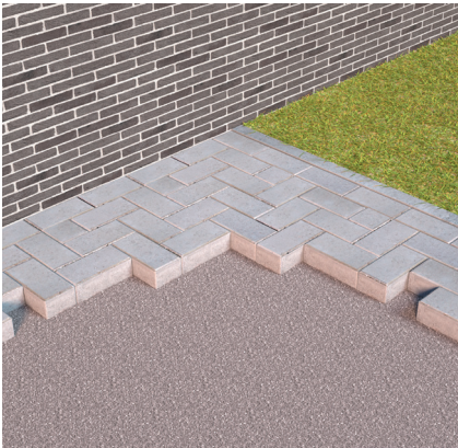
Placement sur stabilisé en appareil à mi-brique
