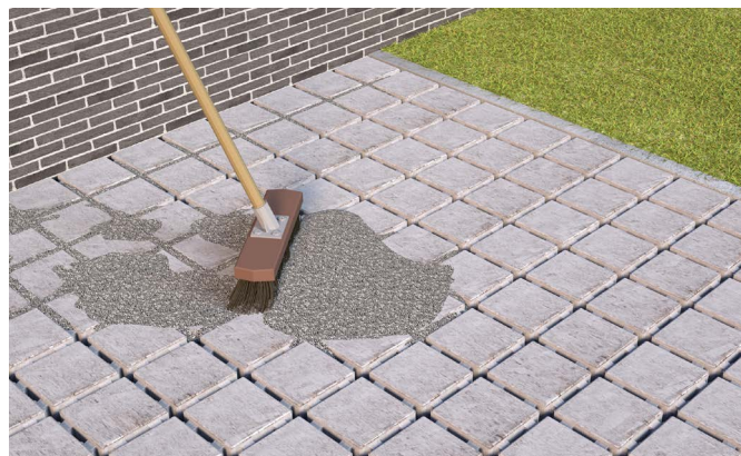
Opvullen met waterdoorlaatbare voegsplit
