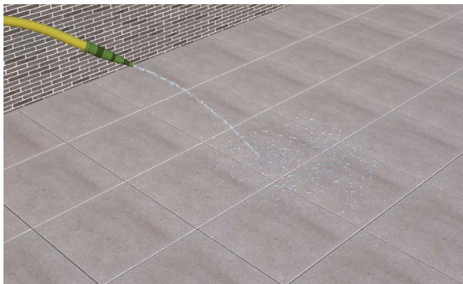
Besproeien met water alvorens te reinigen
