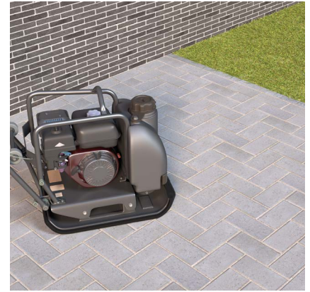
Aftrillen met trilplaat voorzien van rubberen zool
