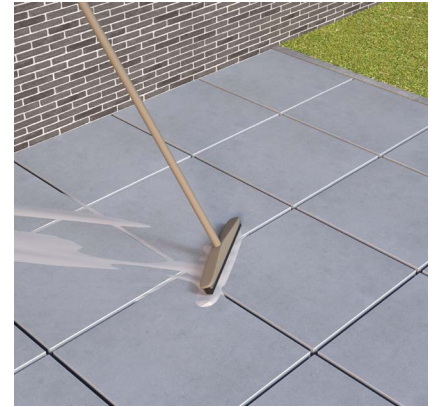
Voegen met voegmortel en voegrubber
