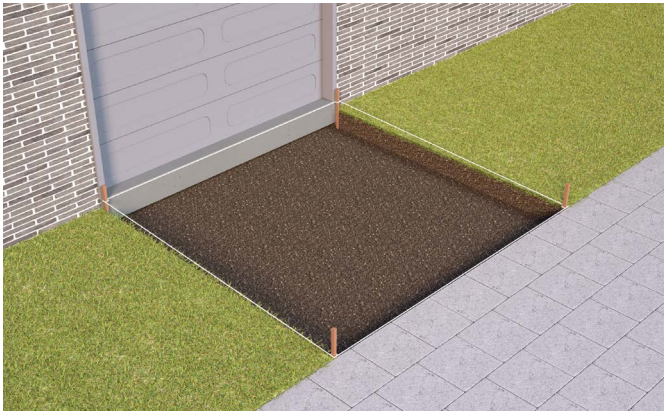
Uitzetten met piketten en niveau bepalen
