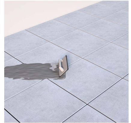
Voegen met voegmortel en voegrubber
