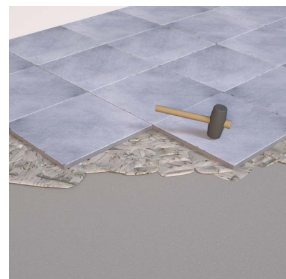
Plaatsing tegels in de legmortel
