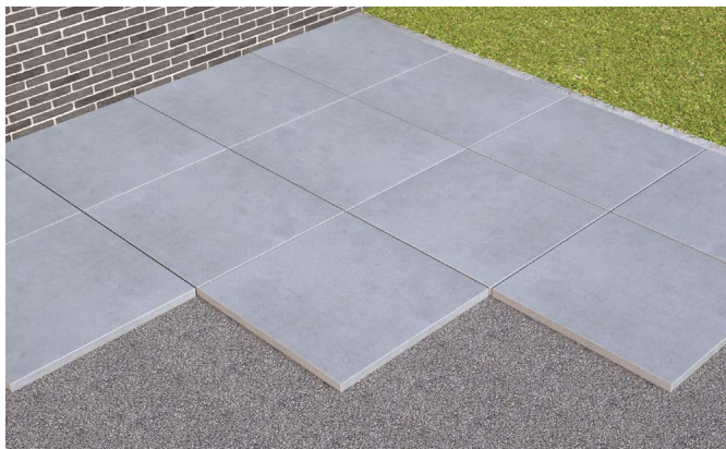
Posez les dalles librement sur gravier
