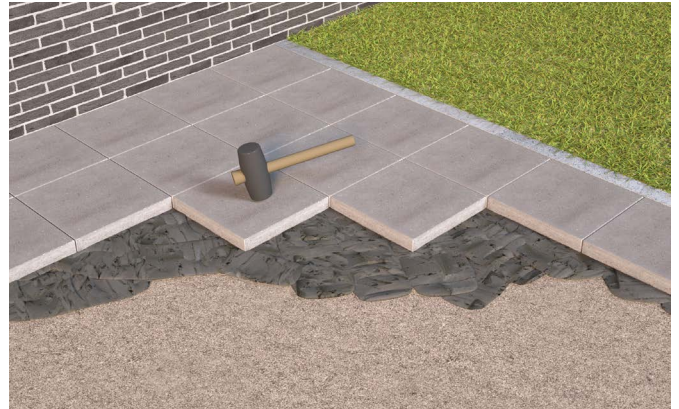
Placement de dalles avec un maillet en caoutchouc
