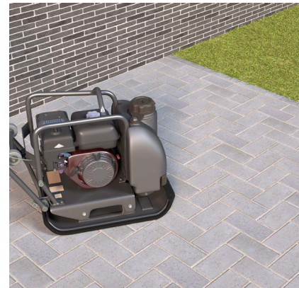
Damer avec une plaque vibrante munie d'une semelle en caoutchouc
