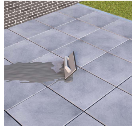
Rejoindre avec un mortier de jointoiment
