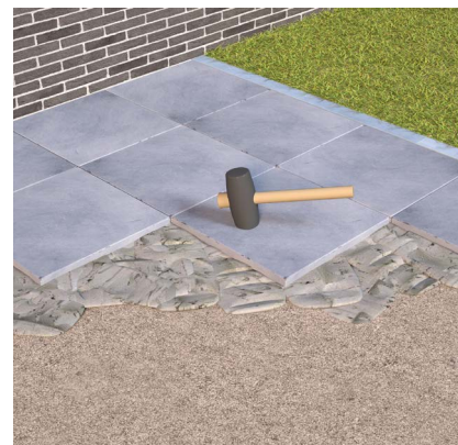
Placement dalles en mortier de pose sur stabilisé
