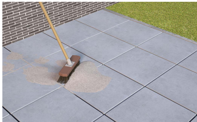
Rejointoyer avec sable de jointoiement ou gravillon
