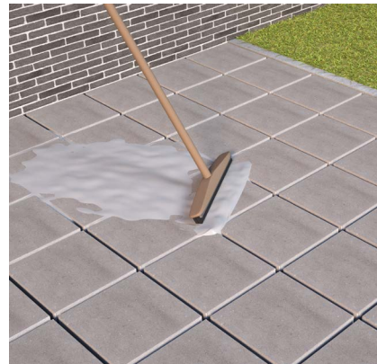
Remplir avec un produit de rejointoiment (pose avec joint)
