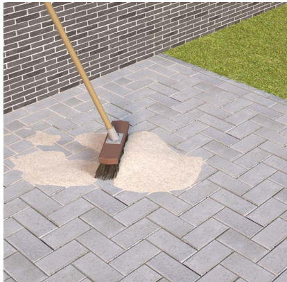
Brossez-les avec du sable de jointoiment / sable bio
