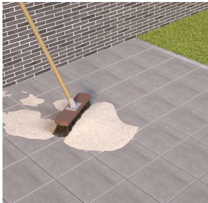
Brossez-les avec du sable de jointoiment (pose sans joint)
