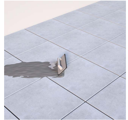
Remplir avec un produit de rejointoiement et raclette à joints
