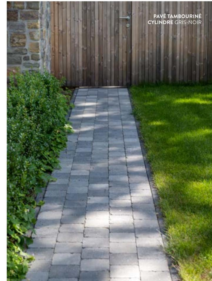
Le tambourinage des pavés peut se faire de deux manières différentes : tambourinés cylindres ou in-line. **Vous préférez un aspect vieilli et rustique ? Optez dans ce cas pour le tambouriné cylindre.** Le pavé subit un traitement de vieillissement dans un cylindre après sa production. Les pavés s'entrechoquent dans le tambour et de petits
